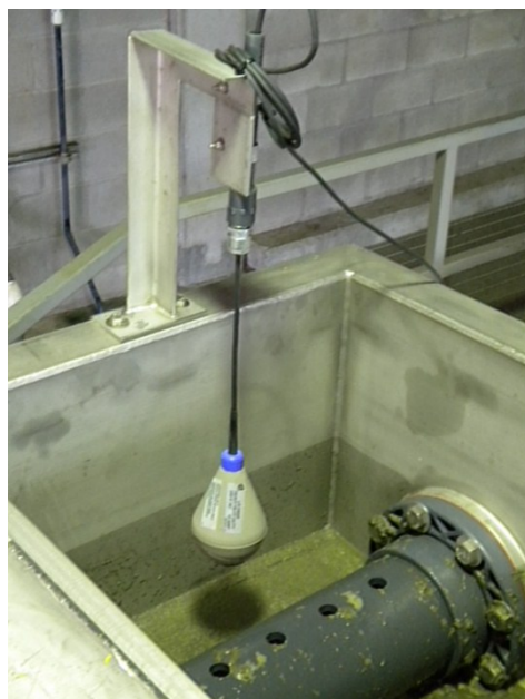
Figure 66 : Flotteur du pilote primEAU
