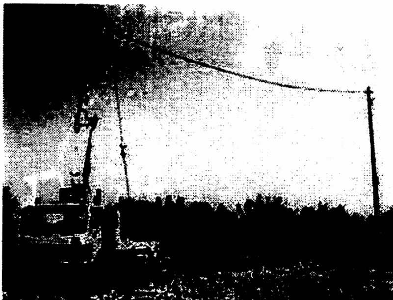
Figure 97 - Essai in situ de flexion composée sur un poteau EDF [Vanackere et coll., 1993].
