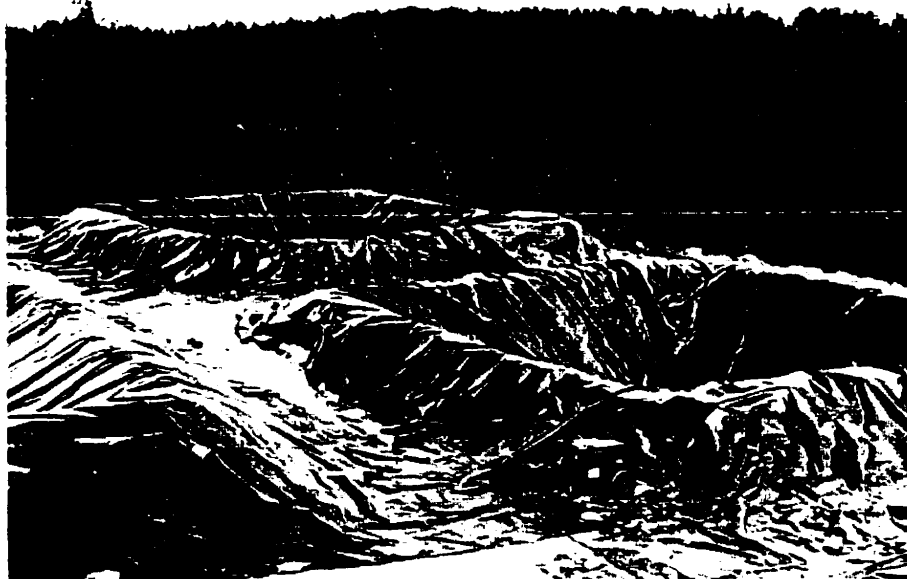
Figure 3.20 : Forme des cellules expérimentales après la mise en place des géomembranes
